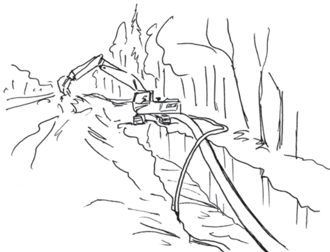
Рис. 4.1.1. Укладка в траншею трубопроводов, смонтированных на поверхности
