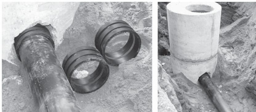
Фото 2.1. Защитные муфты для входа в бетонный колодец
